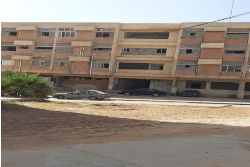
صورة رقم (6) التعديلات في المبنى في محلة لبدة
