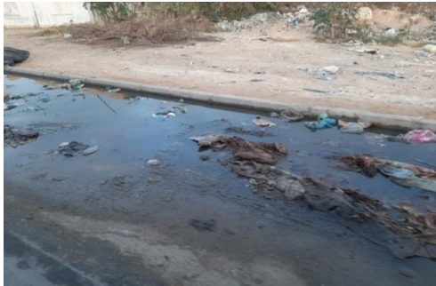
صورة رقم (17) انتشار مياه الصرف الصحي
