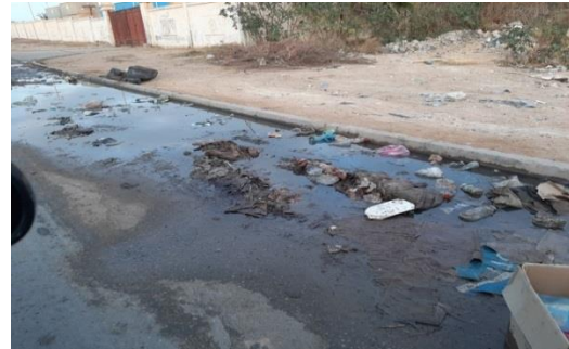
صورة رقم (16) انتشار مياه الصرف الصحي
